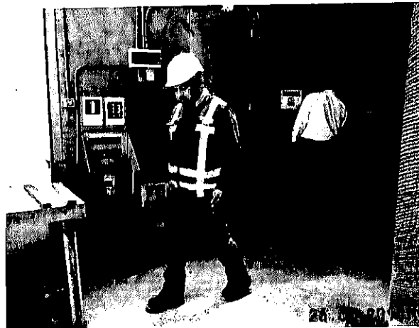
Fotografía N° 2: Materialidad de faena.
